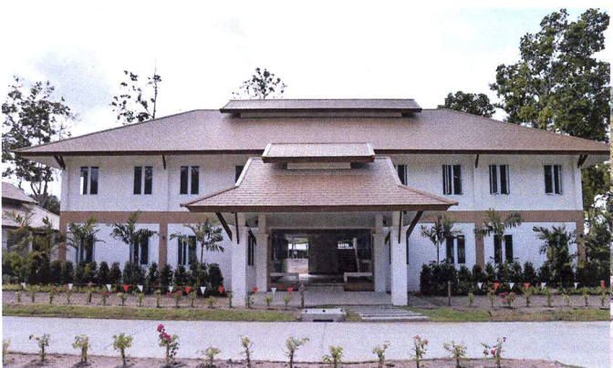
อาคารอำนวยการ
